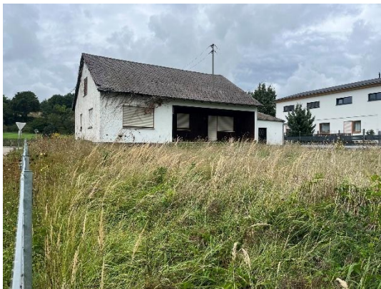
Abb: Blick auf Fl.-Nr. 1103/6 von Süden – Baugrundstück mit Garten, (Quelle: Eigene Aufnahme, Aufnahmedatum 02.09.2025)
