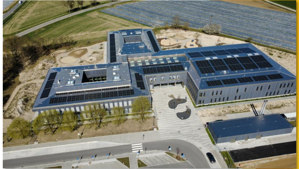
Ansicht Schulgebäude von oben mit Photovoltaikanlage
